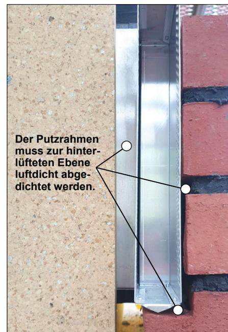
Wird das LUNOtherm-S/-S+ in eine verblendete Fassade eingebaut, ist einer der wichtigsten Punkte die Trennung der Frischluftversorgung der Innenräume von der Hinterlüftung der Verblendung. Die entsprechenden Hinweise dazu finden sich in den Detailbildern.
